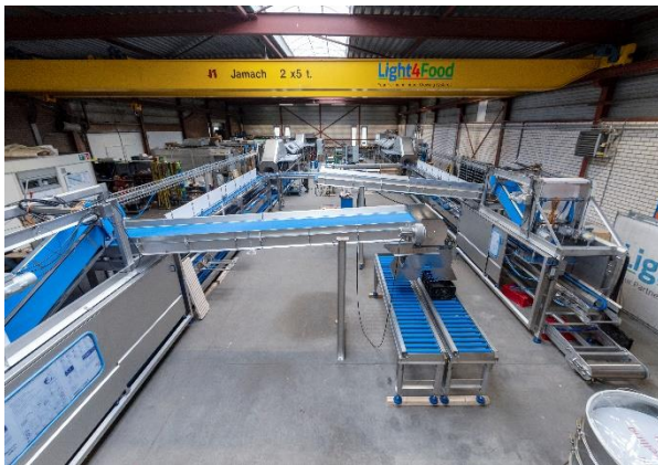
Bouwen van machinelijnen in de fabriek
